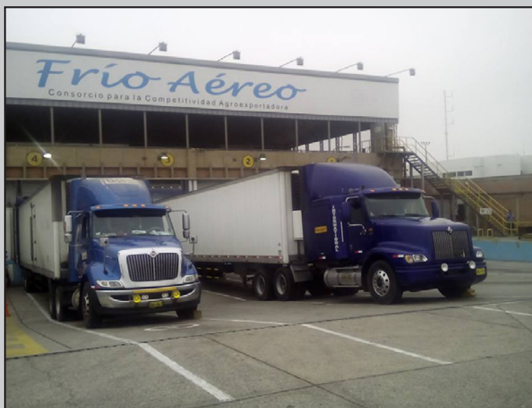
Instalaciones de Frío Aéreo en la sede Principal del Callao
